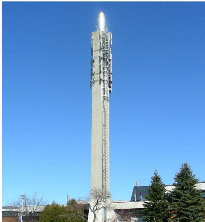
Cheminée de la centrale d'énergie
